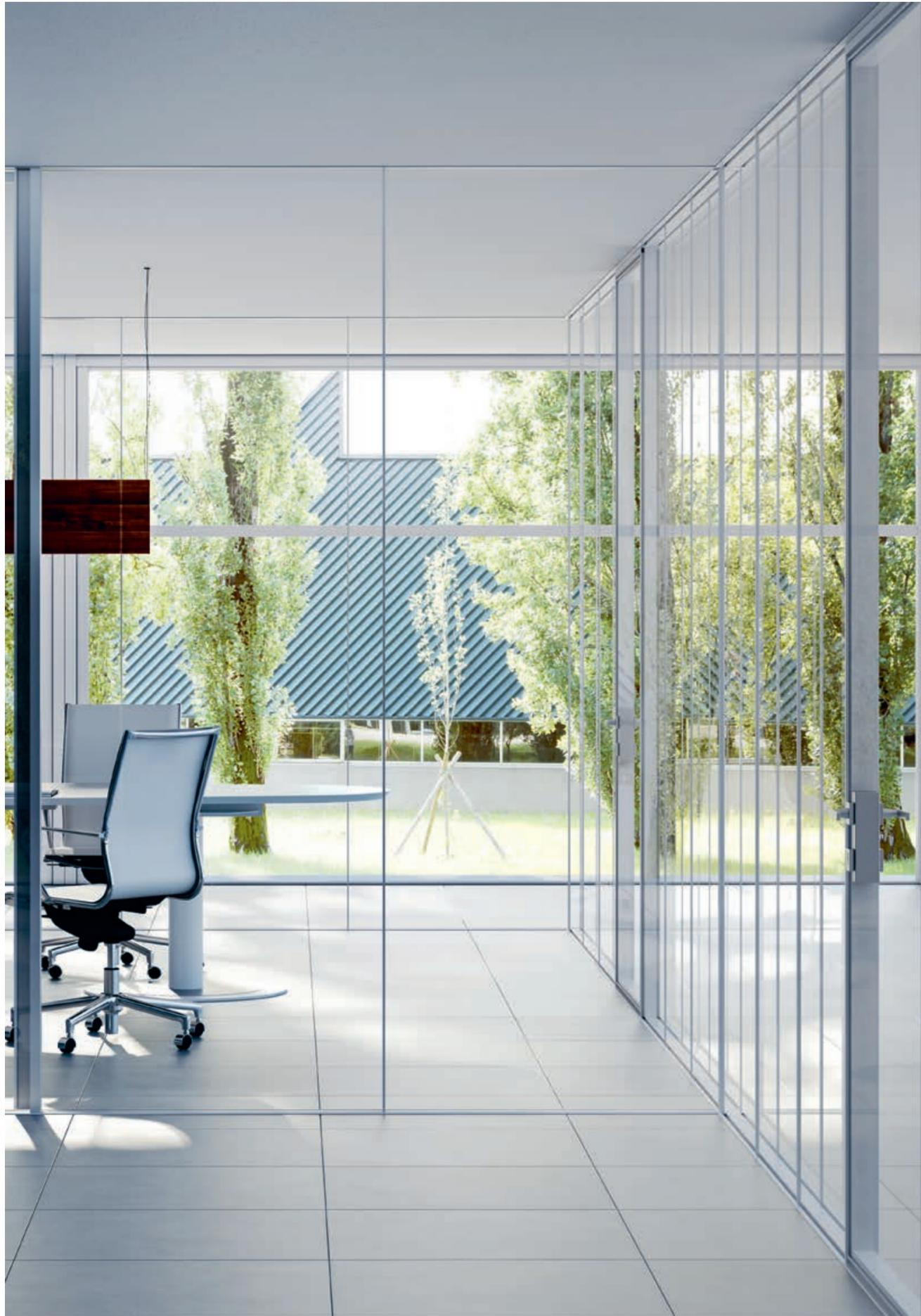
**Integrazione perfetta.** La parete doppio vetro è composta da elementi in vetro a tutta altezza con una struttura in alluminio estruso che consente l'utilizzo di due vetri a filo esterno sullo stesso binario. I profili di questa struttura vengono annegati nel pavimento o nel controsoffitto.
